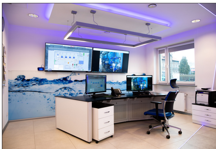
Zakład Wodociągów i Kanalizacji w Nowej Rudzie
