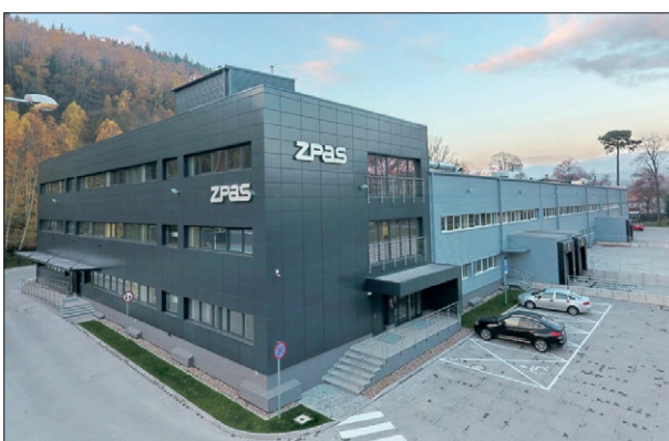
Nowa Ruda, ul. Piłsudskiego Zakład produkcyjny – montaż elektryczny
