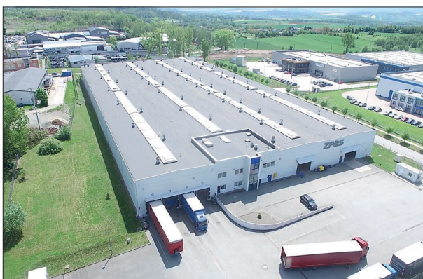
Nowa Ruda - Słupiec, ul. Spacerowa
