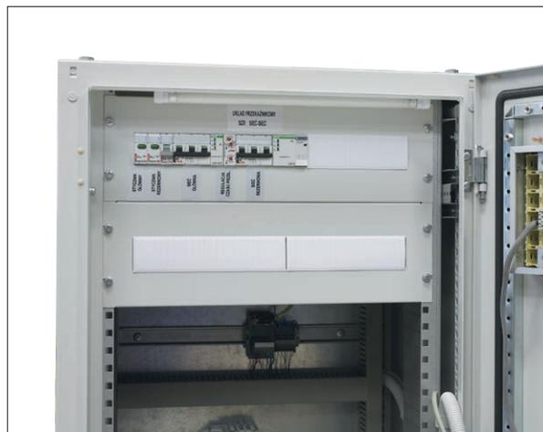
Релейная система АВР, установленная в корпусе шкафа
