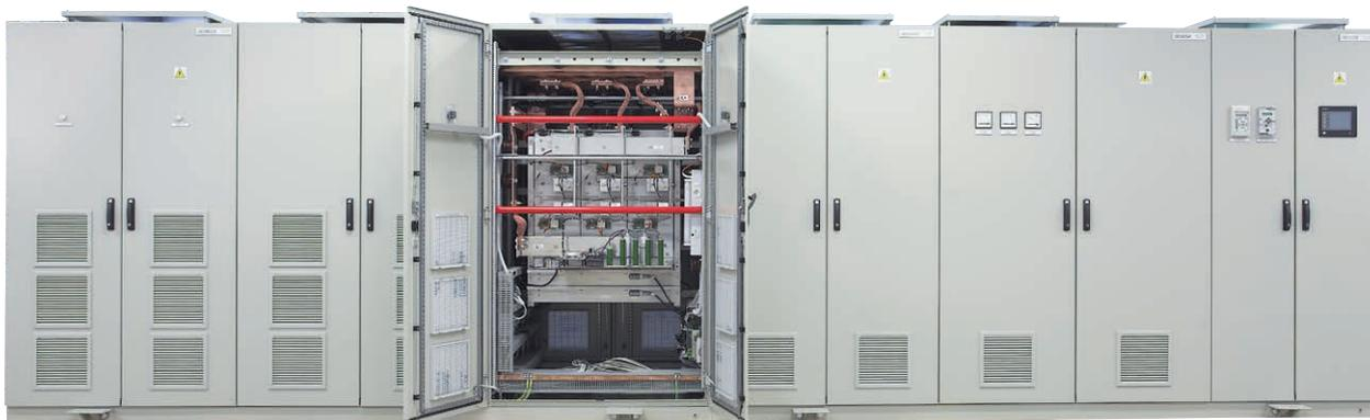
Шкафы возбуждения генераторной установки мощностью 600 МВт
