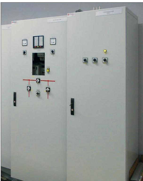
Распределительный шкаф для собственных нужд на напряжение 400/230 В переменного тока запитывается от двух или более источников. В главных цепях питания применяются силовые выключатели или контакторы в соответствии с требованиями проекта. Основным элементом системы является система АВР, проектируемая с учетом требований заказчика.
